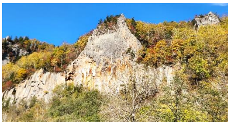
⑨四の岩覆道付近
